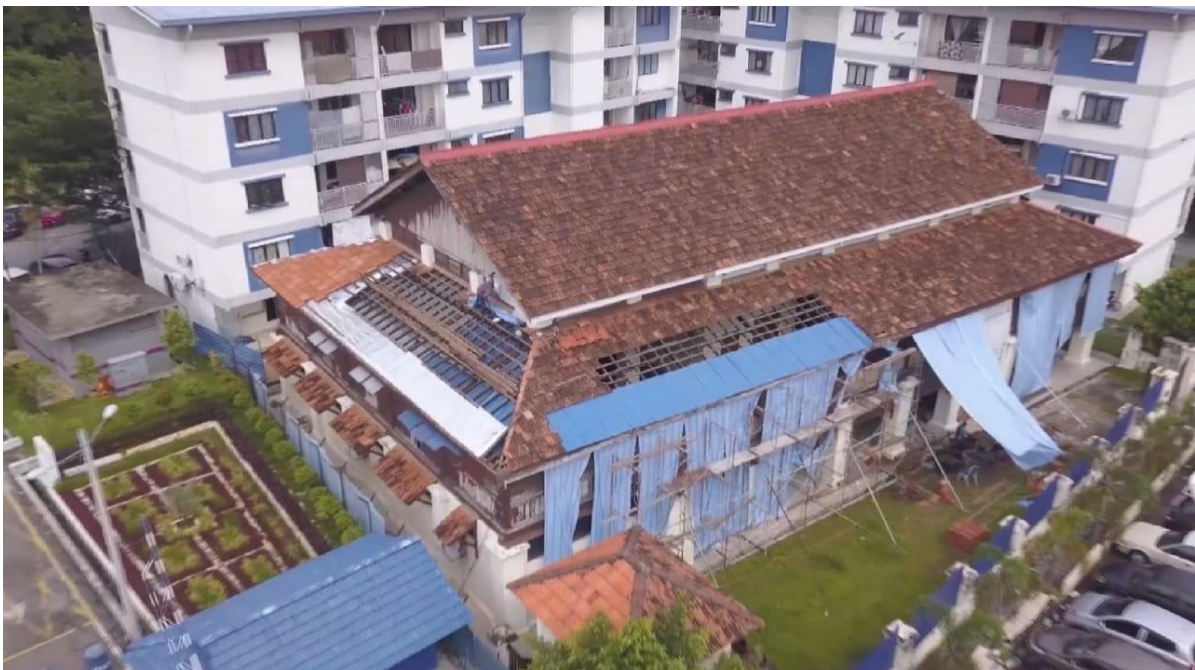
Rajah 8: Gambar Pandangan Dari Udara Keadaan Bangunan Bumbung Gedung Raja Abdullah Semasa Kerja-Kerja Konservasi Oleh PADAT Dilaksanakan Pada Tahun 2019
